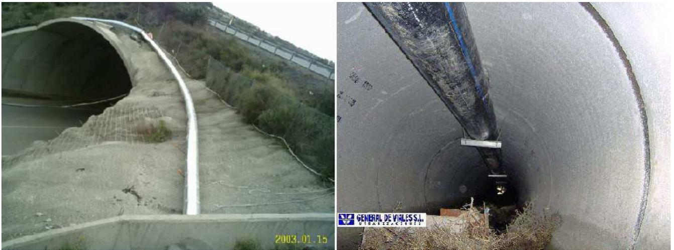
Paso de tubería de polietileno de alta densidad de 315 mm., con soldadura a tope, colocada sobre túnel de la carretera MA-547 a Benahavis, con protección de lamina de acero inoxidable, a la que protegimos con malla cerrada de brezo. Esta misma tubería la colgamos por paso de agua bajo la MA-547, grapada con varillas roscadas con resina epoxi y pletina de cierre.
