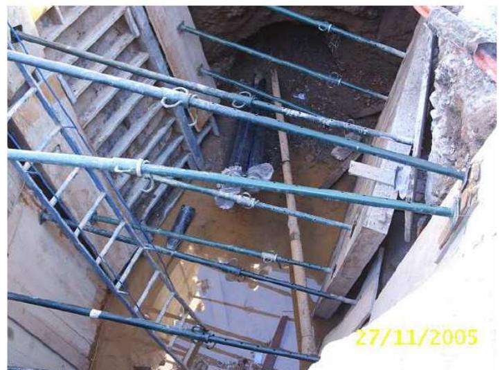
Aspectos de obra, durante la ejecución de zanjas, entibaciones y hormigonado de canalizaciones, todas realizadas con tráfico rodado y tránsito de peatones. Concretamente son de la ejecución de acometida de redes de saneamiento y pluviales a edificio residencia 3ª edad en el Arroyo de la Miel, y obras de interconexión de red de alta tensión por las calles céntricas de Málaga
