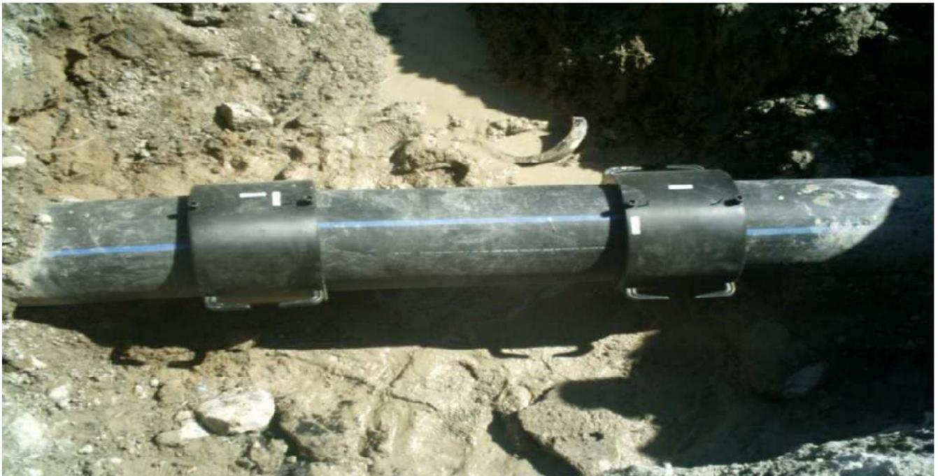
Arreglo de averías de agua, en este caso es una tubería de 250 mm., de polietileno de alta densidad, que reparamos con manguitos electrosodables.
