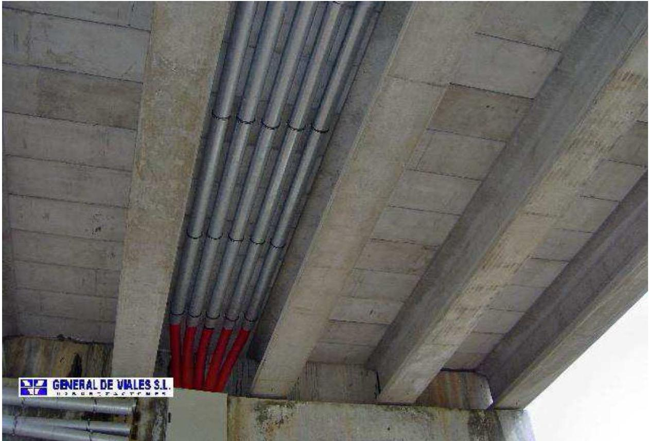
Realizado mediante anclaje a tablero del puente, con abrazaderas de acero al carbono, ancladas con tacos químicos de gran capacidad portante, que sustentan tubos de acero galvanizado de DN 200 mm
