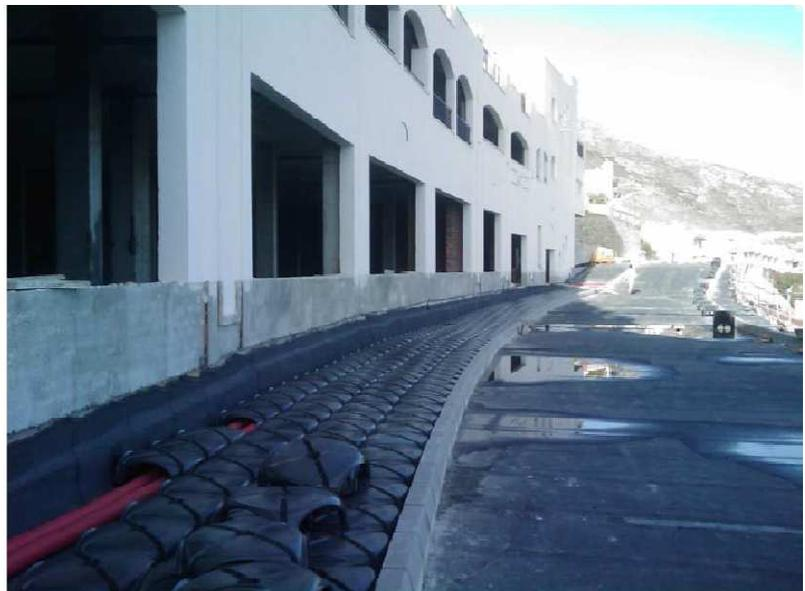
*Impermeabilización sobre cubierta de aparcamientos, sobre la que se ejecuta vial de conexión a Villordo norte, en Benalmádena pueblo. Sobre la impermeabilización se ejecuta una capa de rodadura de asfalto en caliente, y acera de hormigón impreso, que se aligera para no sobrecargar el forjado con casetones de PVC.*
