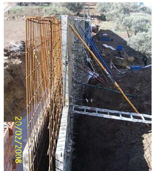
*Hay tajos donde, para la ejecución de estos trabajos es necesarios trabajos en sitio con poco espacio, o con terrenos complicados, por lo que nos exigen obrar mediante bataches, o con elementos de ejecución especiales.*
