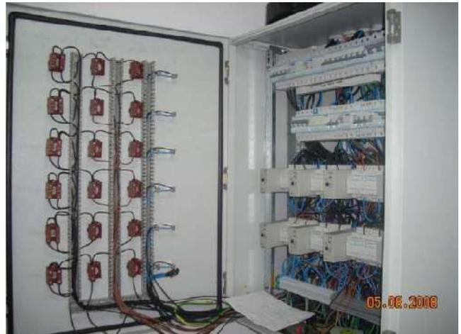
*Equipo para abastecimiento a urbanización Las Chapas, con cuatro bombas de caudal variable y arranque alternativo, con su equipo de maniobra y control.*
