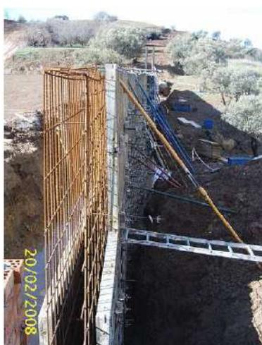
*Ejecución muro hormigón en Colmenar.*
